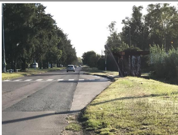
Dársena existente a reacondicionar, Etapa 1 mano a Berisso
