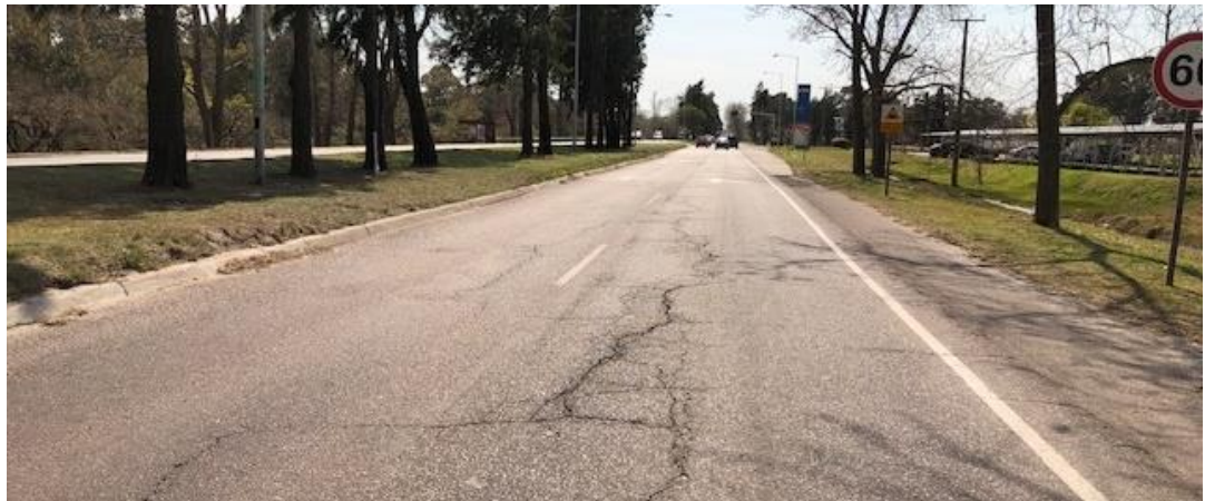
Ilustración III-3: Mano a Berisso a repavimentar, carpeta asfáltica deteriorada.
