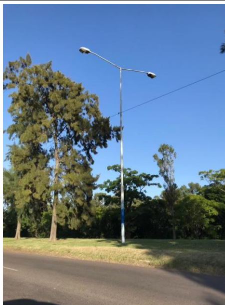
Luminarias existentes a reemplazar por LED
