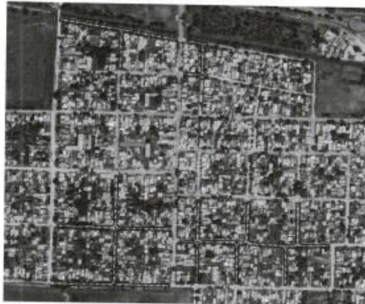
Ilustración II - Imagen general calles proyectadas a pavimentar – Berisso
